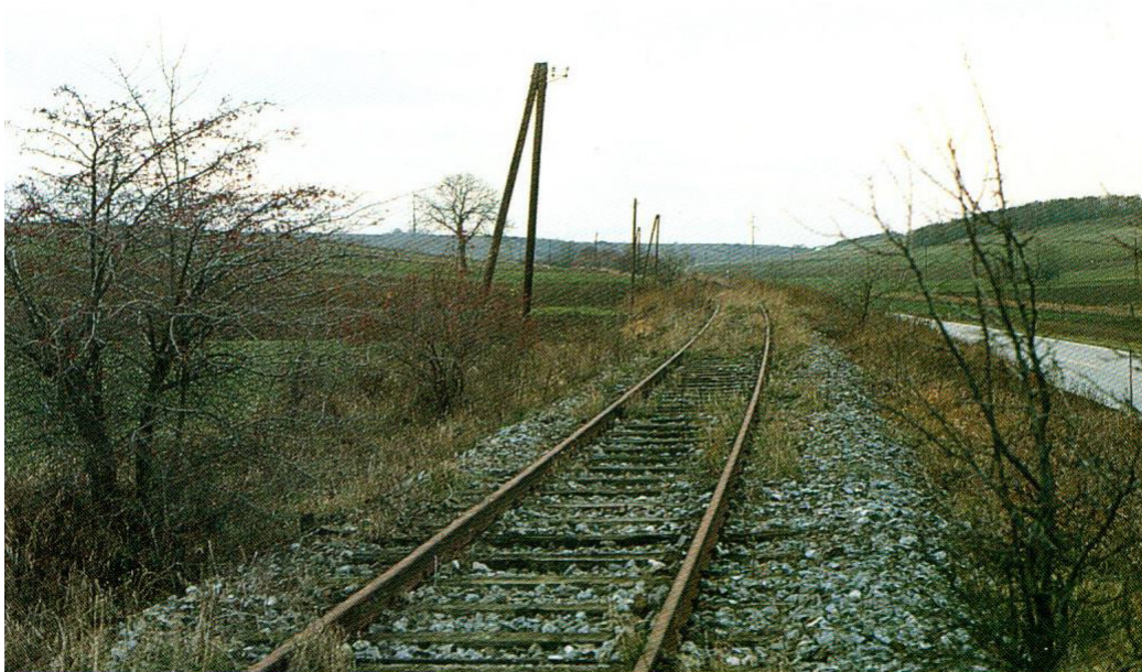
Abb. 5: Zustand der Bahnstrecke westlich von Kleinhadersdorf im Jahr 1992. Gleise, Bahnschwellen sowie die Trassen begleitende Leitung sind noch vorhanden, ebenso ist beginnender Gehölzaufwuchs zu erkennen. / State of the railway line west of Kleinhadersdorf in 1992. Tracks, sleepers and the cable along the railway line are still present; beginning growth of wooded vegetation is visible. Quelle: Berg & Zelz (1994).
