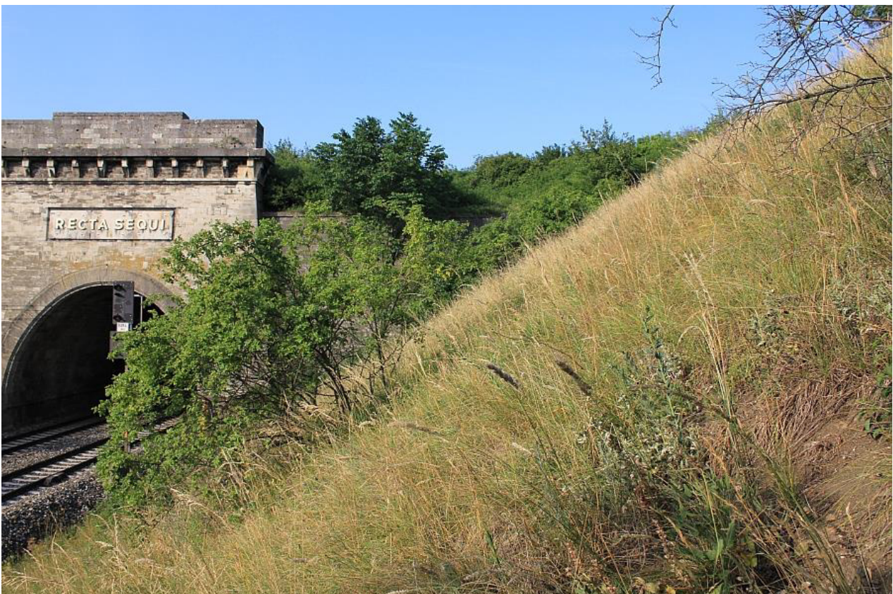
Abb. 4: Das Nordportal des Busserltunnels mit einem Halbtrockenrasen am Steilhang. / The northern entrance of the „Busserltunnel“ with an adjacent dry grassland on a steep slope. 20.6.2012, © Norbert Sauberer.
