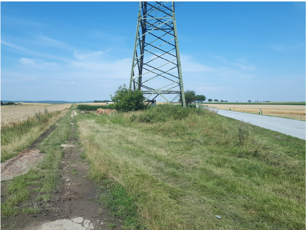
Abb. 3: Mastfußbereich des Mastes 437-M0107 in Sitzendorf an der Schmida. / Base of pylon 437-M0107 in Sitzendorf an der Schmida. 19.7.2019, © Günther Wöss.
