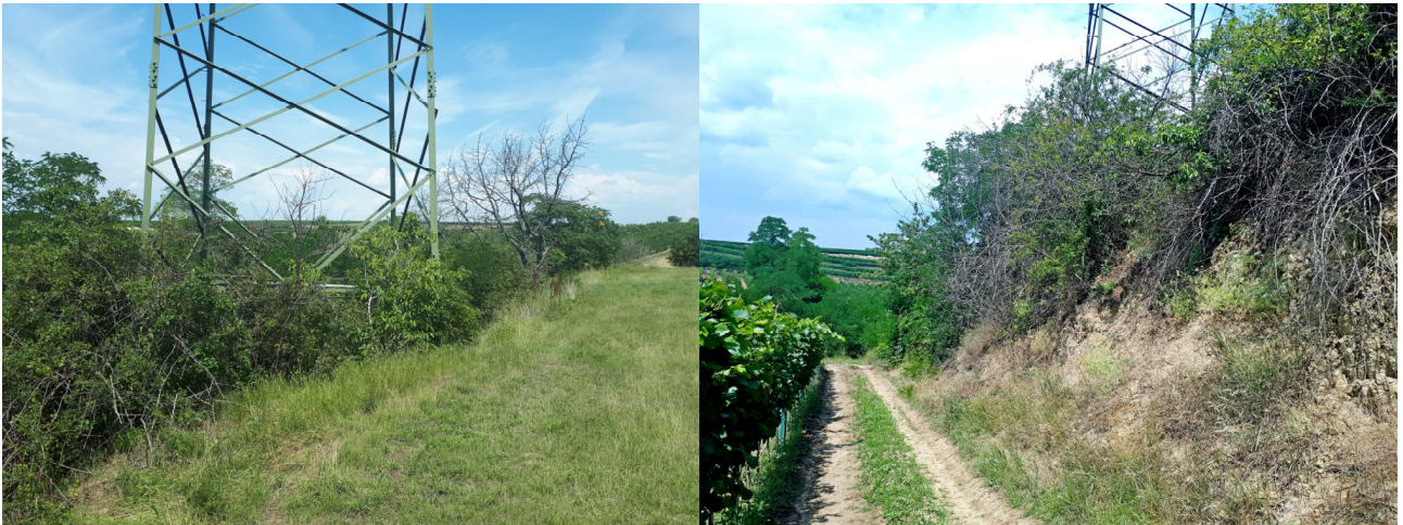
Abb. 1 (links/left): Mastfußbereich des Mastes 437-M0165 mit östlich angrenzendem Wiesenstreifen. / Pylon base area of pylon 437-M0165 with adjacent meadow strip to the east. 19.7.2019, © Günther Wöss.
